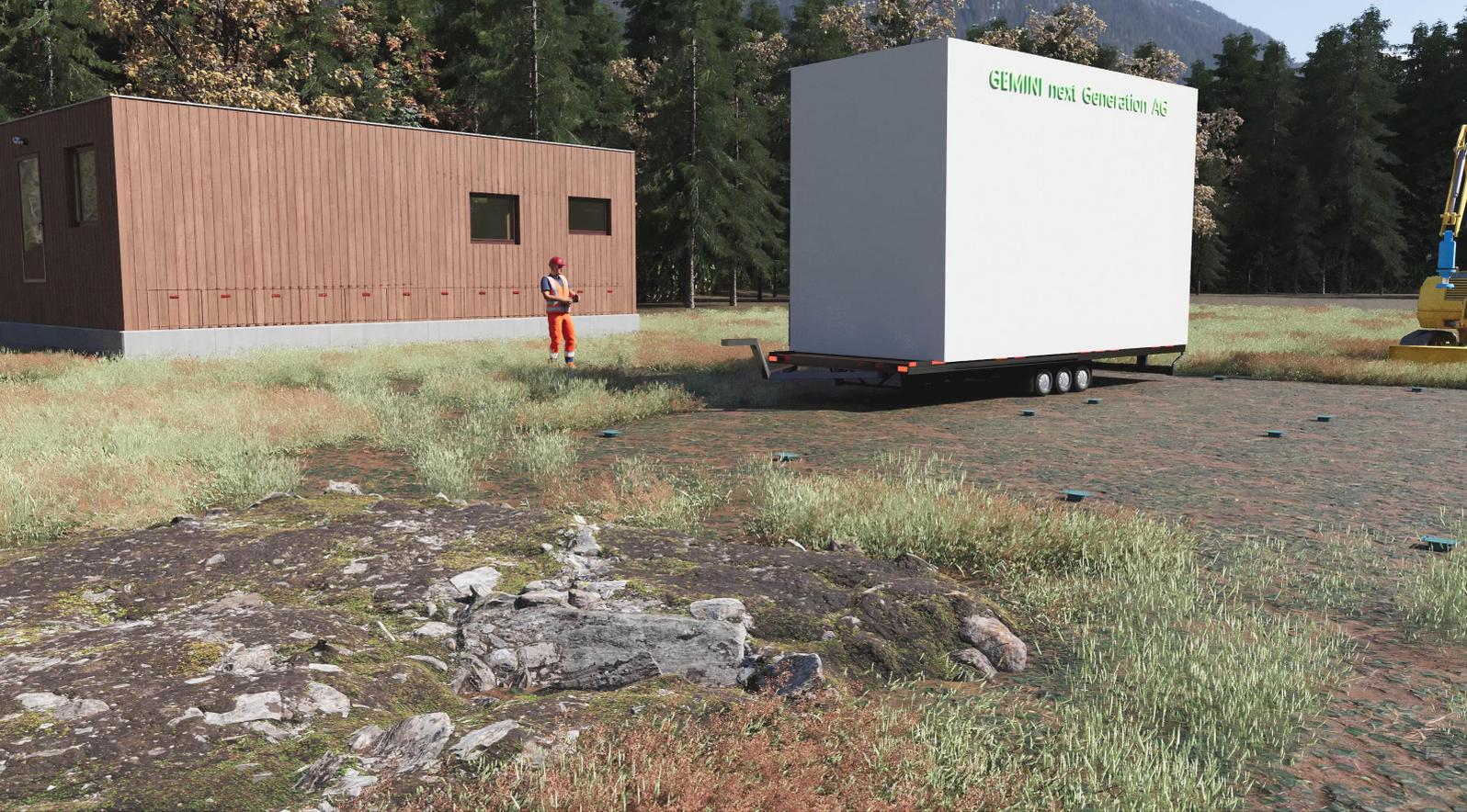
*Der Anhänger wird positioniert, dann kann das Haussegment mit den Fundamentschrauben verbunden werden.*
